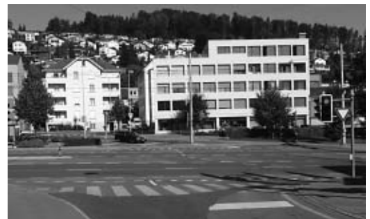
B) Querung der Luzernerstrasse, um von der Radroute Luzern-Kriens zur Hofstetterstrasse zu gelangen
