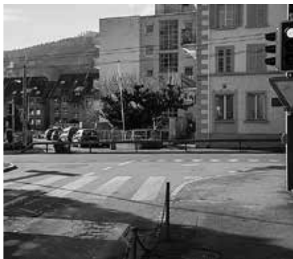
Von der Zumhofstrasse gäbe es eine praktische Querung Richtung Südstrasse, wenn nur die Leitplanke nicht wäre ...
