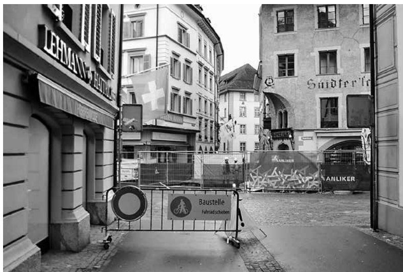
Sicht aus der Rütligasse. Fälschlicherweise steht hier ein Fahrverbot, obwohl die Durchfahrt nach links und rechts zulässig ist.
