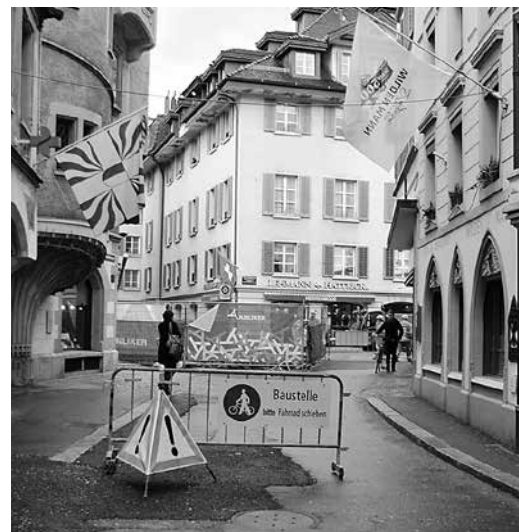
Sicht aus der Bahnhofstrasse. Das (notabene falsche Schild ohne Fahrverbot) steht viel zu weit vor der effektiven Baustelle.
